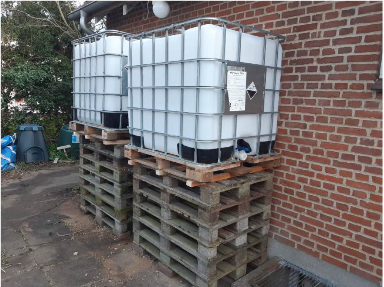
2 x 1000 l vandtanke, hævet på paller for at øge vandtryk
